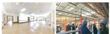
左:ツアーで視察した特別養護老人ホーム。木造でも大スパンの空間が可能。木造特組壁工法2階建て延べ床面積1658.47㎡。右:構造見学会では、セルコホームが受注した認定ことも園の施工現場が会場となった。木造枠組壁工法2階建て延べ床面積は1377.22㎡
