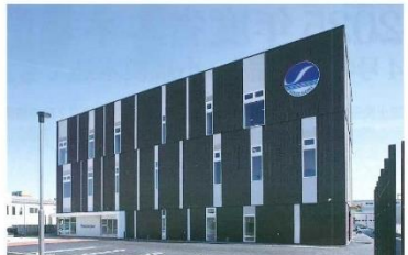
セルコホーム東北支店「シティブロレスト宮城野ビル」。木造ハイブリッド工法8階建て。延べ床面積983.11㎡
